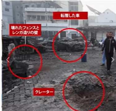
クレーターと壊れたフェンス
